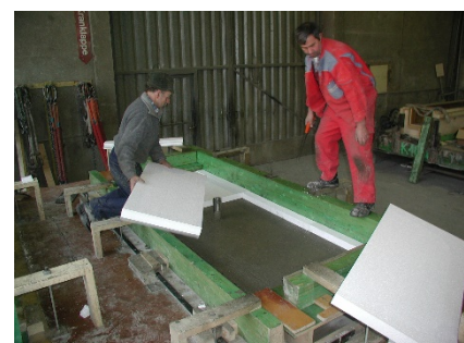
2. Einlegen der Wärmedämmschicht
