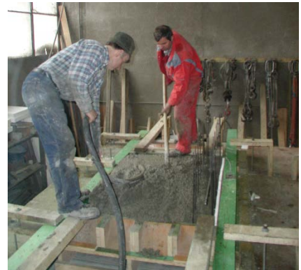
3. Auffüllen der Tragschicht
