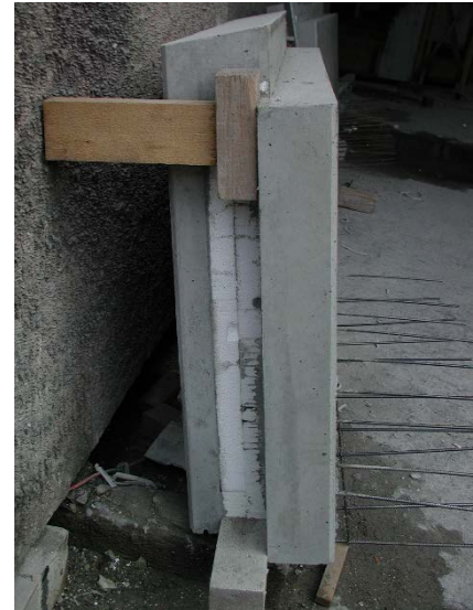
Aufbau der Sandwichplatte
