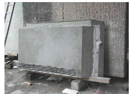
Fertige Sandwichplatte mit Abschlussbewehrung
