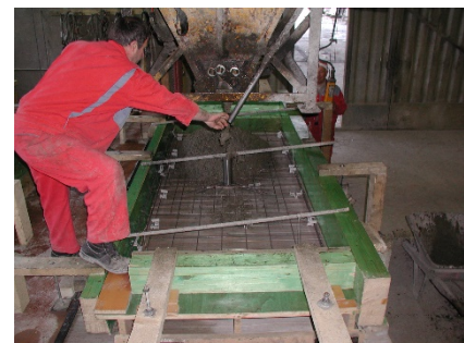
1. Einfüllen der Vorsatzschicht
